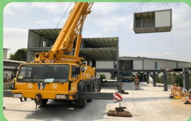
Adoption of Modular Integrated Construction (MiC) 採用「組裝合成建築法」技術
